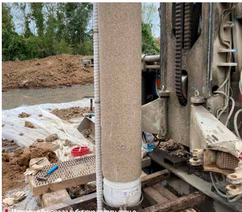
■ Изградња бунара за дубинско одводњавање
